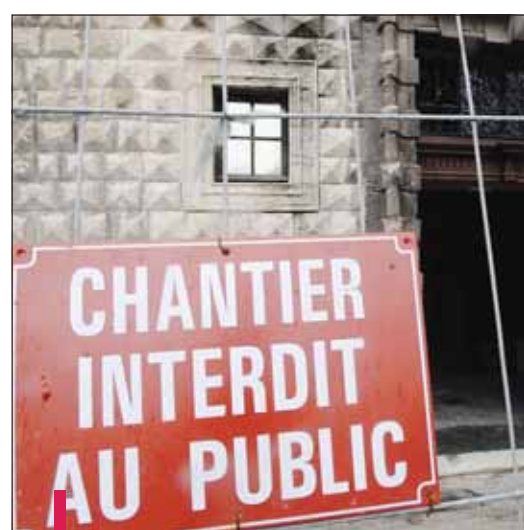
Alors en travaux, la Maison diamantée derrière sa jolie façade qui lui vaut son nom. / E. COULOT
