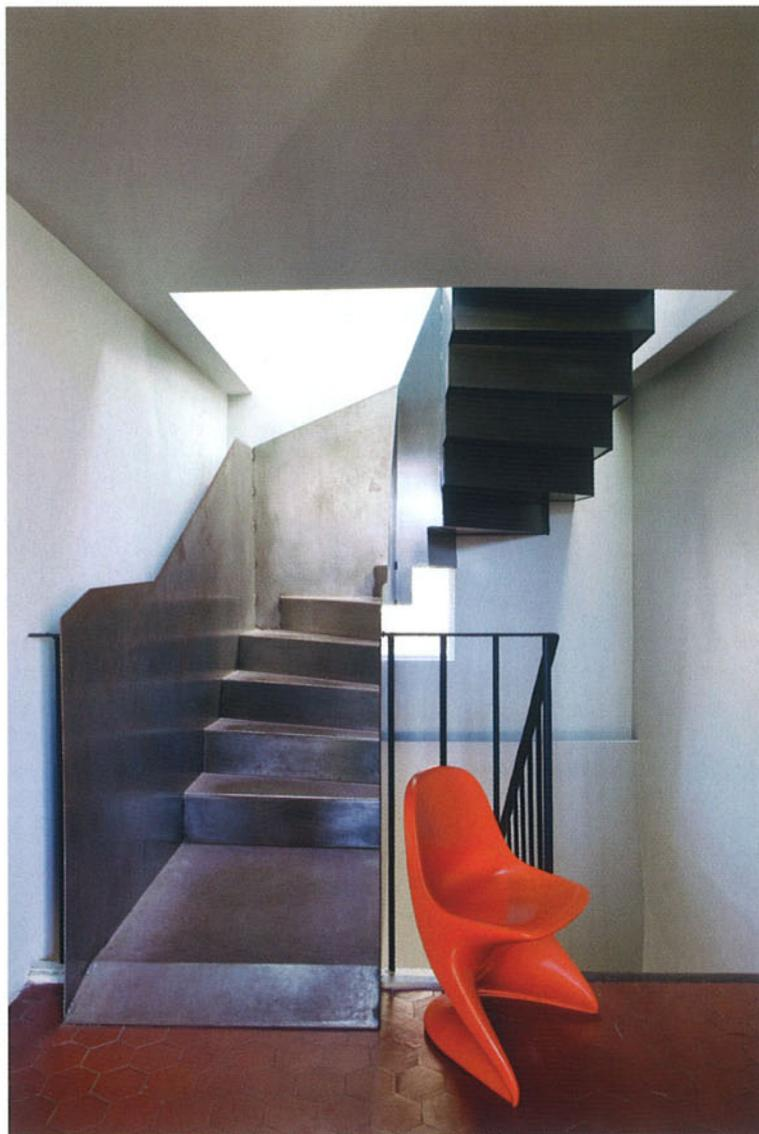
**Bien que faisant suite à un escalier classique,** l'escalier qui dessert les combles est sculptural. Réalisé en tôle pliée de 3 mm d'épaisseur, il doit sa rigidité structurelle et sa tenue à son pliage. Composé de six morceaux assemblés sur place, il est simplement posé entre les deux étages.
